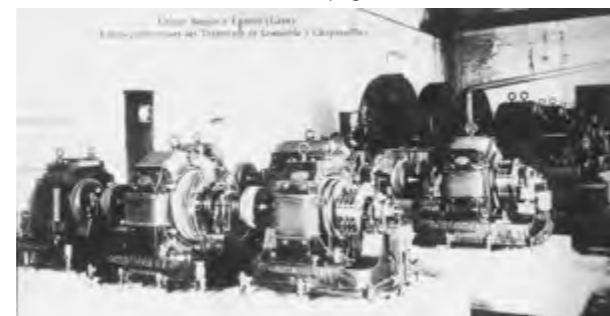
Centrale à Lancey. Forces génératrices des Tramways de Grenoble à Chapareillan
