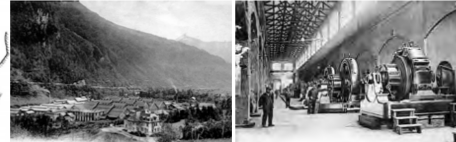
(G) L'usine de Chedde à Passy, au premier plan le « château » de Georges Bergès. (D) La salle des machines et les alternateurs de la centrale électrique qui alimente l'usine. Sources : Pierre Dupraz
