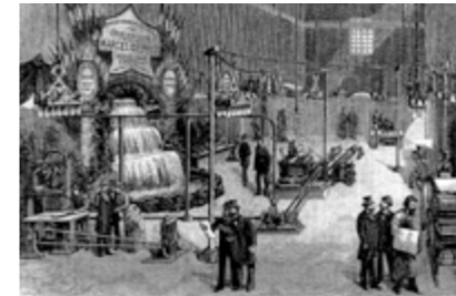
Transport électrique de la force de Jarrie à Grenoble, 1883. Arrivée de la ligne à la halle de Grenoble.
