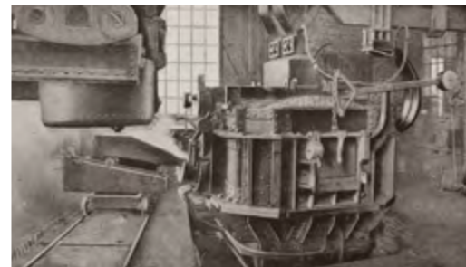
Four électrique à sole conductrice, système breveté Charles-Albert Keller, pour la fabrication des obus en fonte synthétique.
