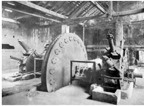
Râperie Bergès à Lancey. La turbine « parapluie » - © 10R2006 2 1841.
