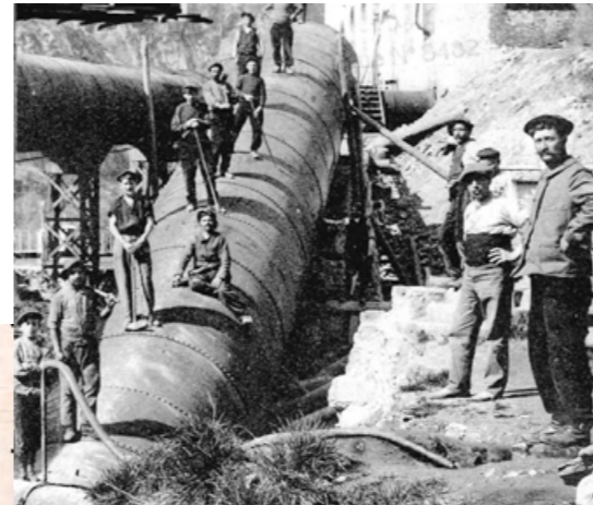
Papeterie de Rioupéroux : (G) Travaux sur les conduites forcées en 1902 - (D) L'arrivée des 2 conduites à la centrale construite en 1913. Source : André Ducluzaux - La Houille Blanche de Belledonne à la Romanche.
