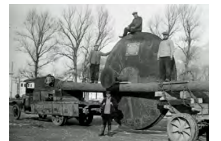
Lancey, turbines « parapluie » de 4 mètres de diamètre.
