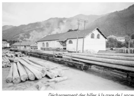
Déchargement des billes à la gare de Lancey.
