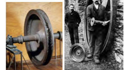
Turbine en fonte à sept branches d'un diamètre de 2,4 m avec son injecteur interne centrifuge • Maison Bergès à Lancey.
