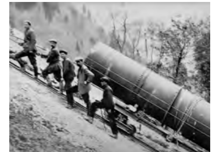
Installation de la conduite forcée.
