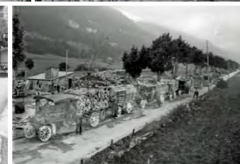
Transport des billes de bois : (H) par tricâble, (B) par transport routier.
