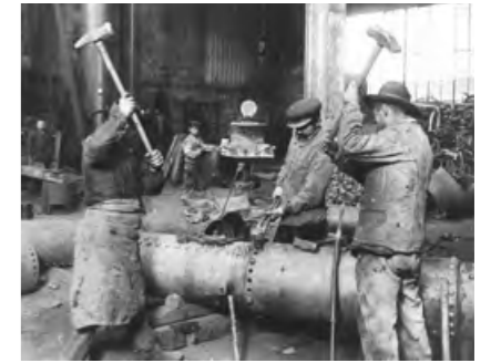
Lancey, rivetage des conduites.
